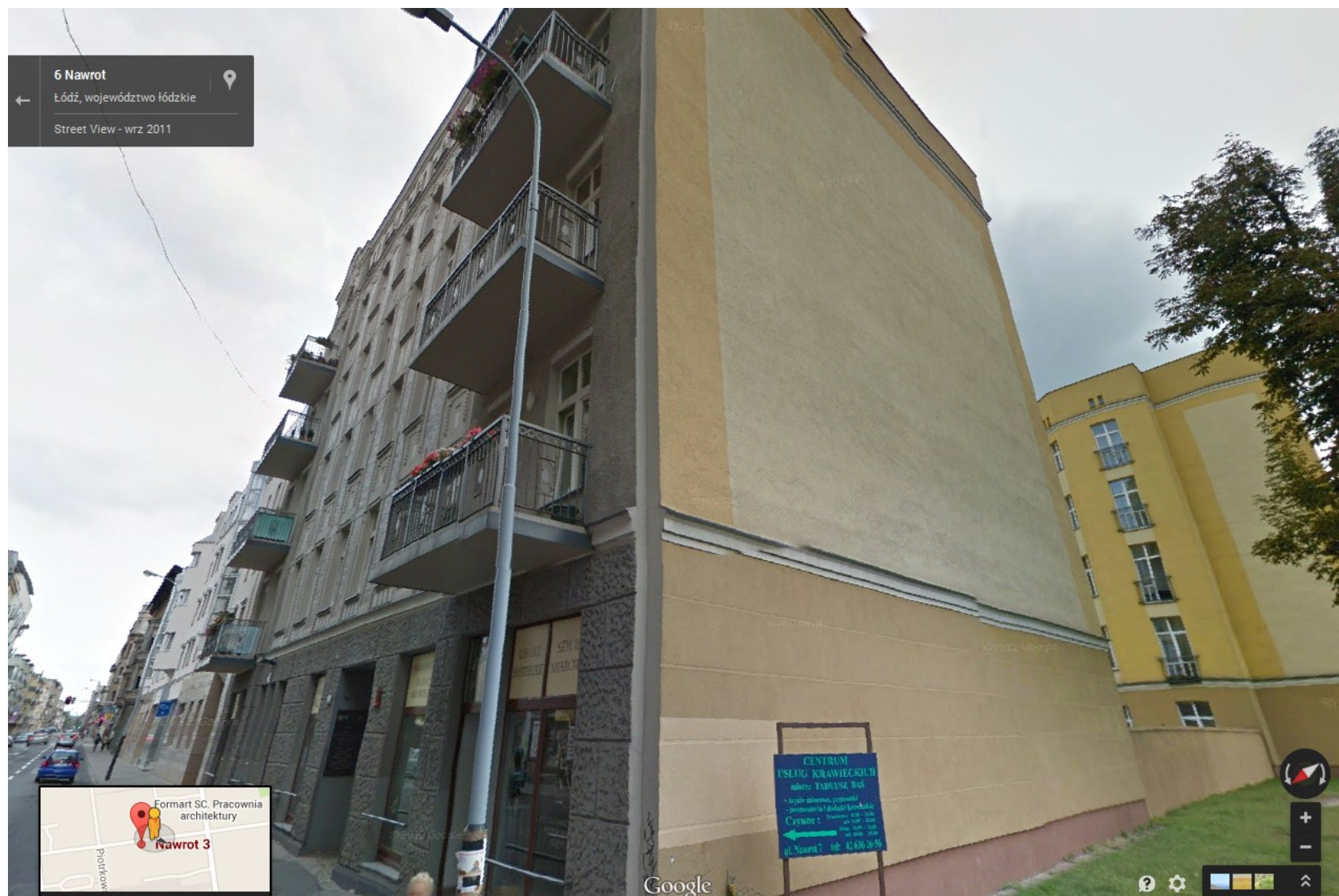
Rys. 5 Zdjęcie wschodniej strony nieruchomości przy ul. Nawrot 3/5 wraz z elewacją kamienicy przy ul. Nawrot 7
