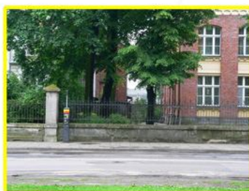
Parkan kuty na konstrukcji betonowej - ul. Czerwona 6
