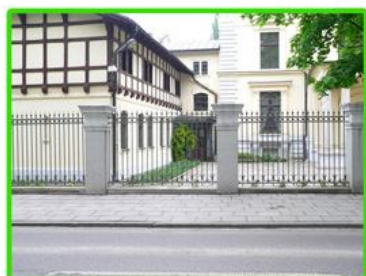
Parkan kuty na konstrukcji betonowej - ul. Tymienieckiego 40
