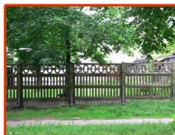
Ogrodzenie betonowe prefabrykowane - ul. Przybyszewskiego 27
