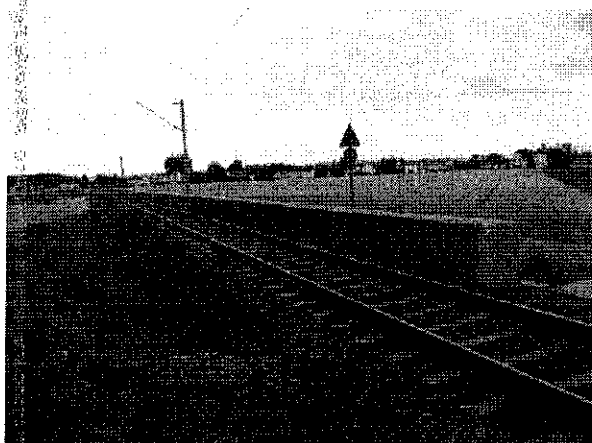
Rys. 24 Niski ekran przeciwhałasowy (wysokość 0.75 m) - (DB Netze: Innovative Maßnahmen zum Lärm- und Erschütterungsschutz am Fahrweg, Schlussbericht, 15.06 2012)
