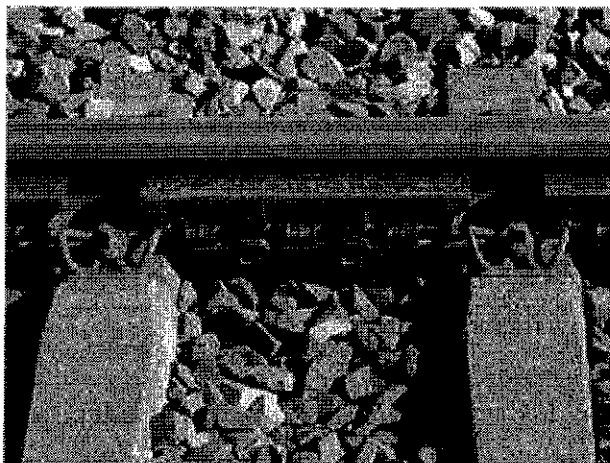
Rys. 23 Tłumiki drgań (DB Netze: Innovative Maßnahmen zum Lärm- und Erschütterungsschutz am Fahrweg, Schlussbericht, 15.06 2012)
