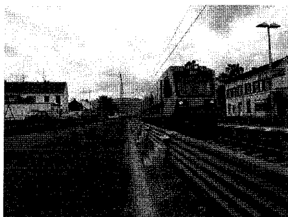
Rys. 24 Niski ekran przeciwhałasowy (wysokość 0.75 m) - (DB Netze: Innovative Maßnahmen zum Lärm- und Erschütterungsschutz am Fahrweg, Schlussbericht, 15.06 2012)
