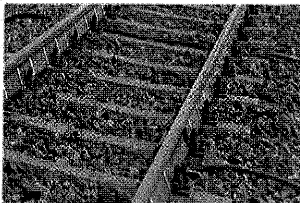
Rys. 22 Oslony szyn (DB Netze: Innovative Maßnahmen zum Lärm- und Erschütterungsschutz am Fahrweg, Schlussbericht, 15.06 2012)
